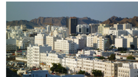
Muscat, Oman Dezentralisierte Verkehrssteuerung
