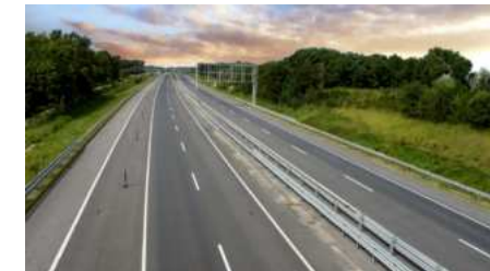
Maďarsko, dálniční síť
